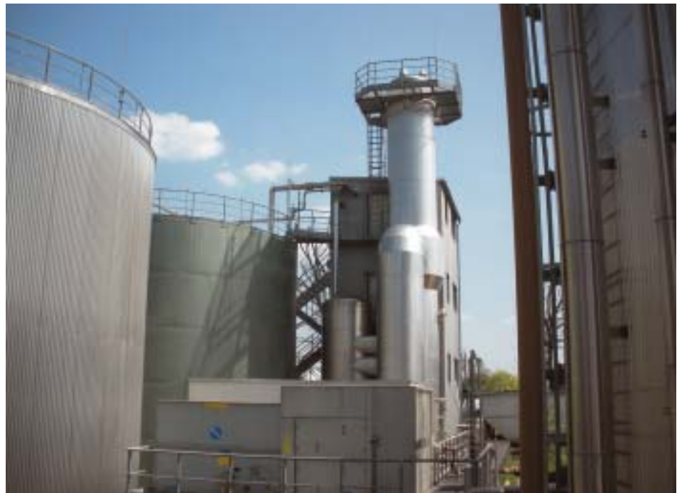
Produkttanklager und Emulsionsverdampfungsanlage der Südöl Mineralöl Raffinerie GmbH in Eisingen
