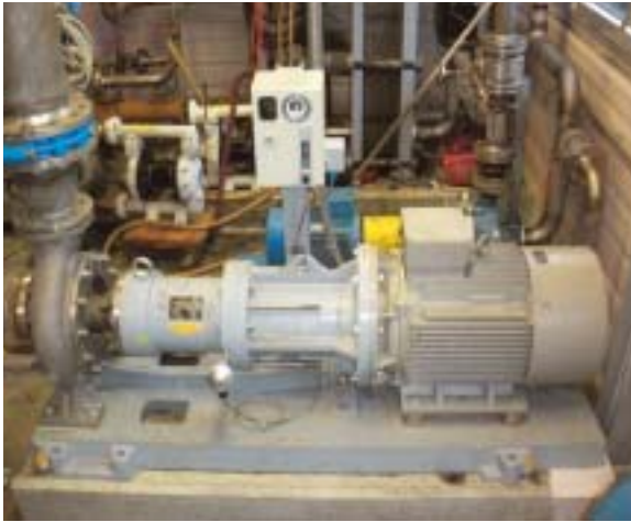
Unkompliziert: die Umrüstung auf die horizontale magnetgekuppelte Kreiselpumpe MPCH DryRun von Bungartz
